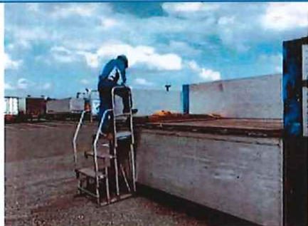
墜落・転落防止：昇降台の導入
